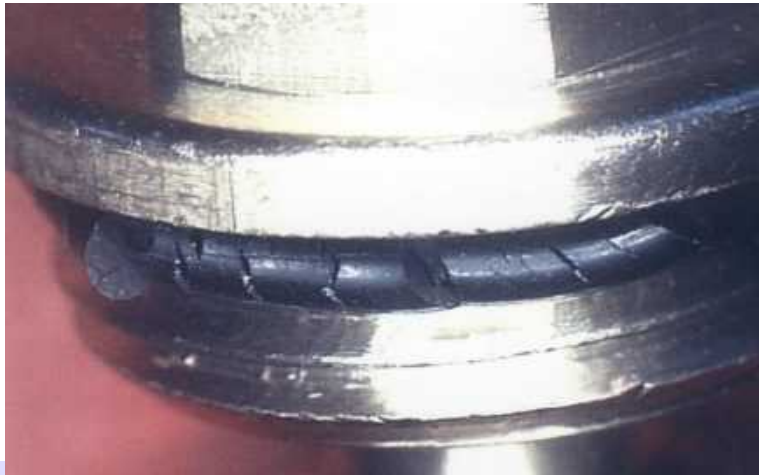
Abb. 19: Vormontierter O-Ring, der durch die Vorspannung und Ozon aus der Umgebungsluft nach mehreren Wochen Ozonrisse aufwies
